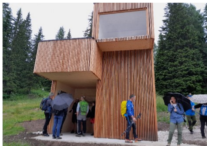
Endpunkt 1. Etappe Infopoint Kreuzbergpass
